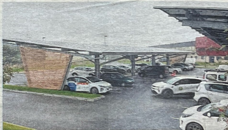
Les ombrières du Pôle d'échange multimodal de Romagné sont surmontées de panneaux photovoltaïques. Archives
